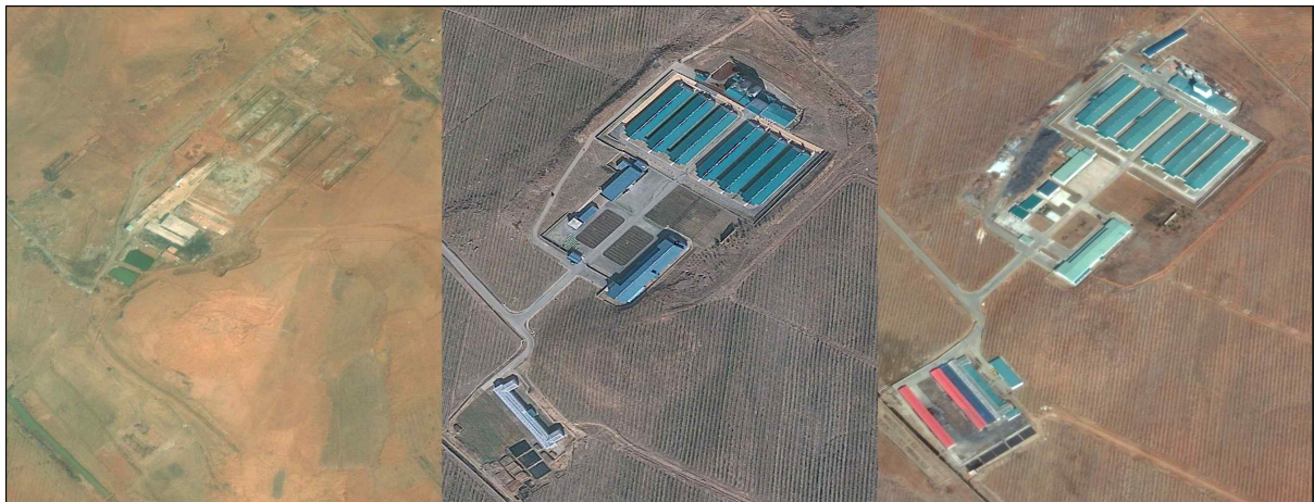
[그림 4] 대동강돼지공장/ 유기질복합비료공장 건설과정
