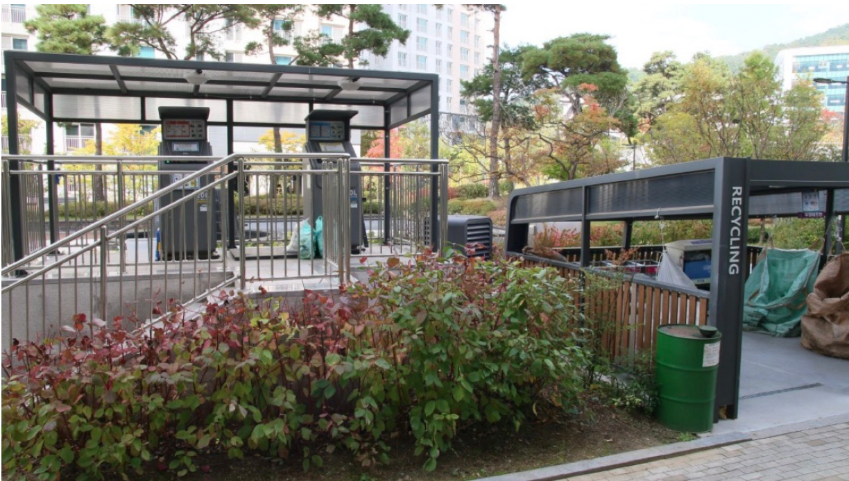
그림 2 세종시 한 아파트단지 내 크린넷 투입구. 왼쪽에 일반쓰레기용 투입구와 음식물쓰레기용 투입구가 나란히 위치해있고, 오른쪽에 재활용폐기물 배출 구역이 위치해있다. (출처: 본인 촬영. 세종시)
