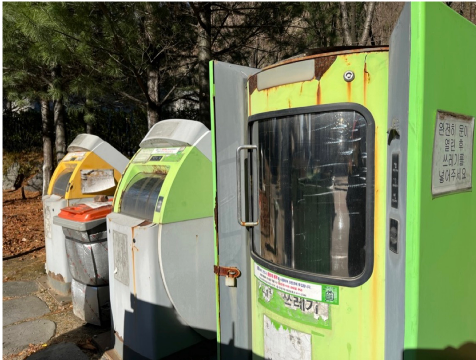
그림 11 대전의 한 아파트 단지. 녹이 쓴 자동크린넷 투입구들 사이로 음식물폐기물 수거함이 놓여 있다. (출처: 본인 촬영, 대전시)
