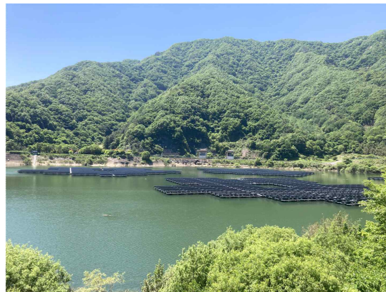
<사진 24> 하부댐에 설치된 태양광 패널
